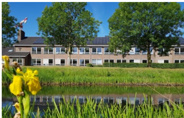
▲ Panelen op het dak van Zodiac
