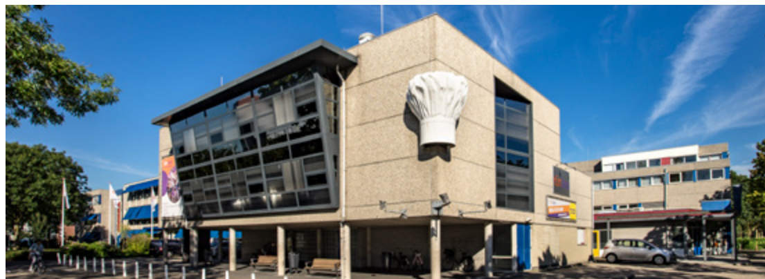
Dit gebouw van de Vakschool mag worden gesloopt.
