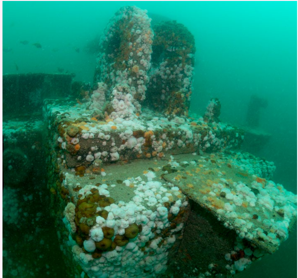
Een deel van de overwoekerde voet van voormalige gasplatform Halfweg. Foto Udo van Dongen, Bureau Waardenburg
