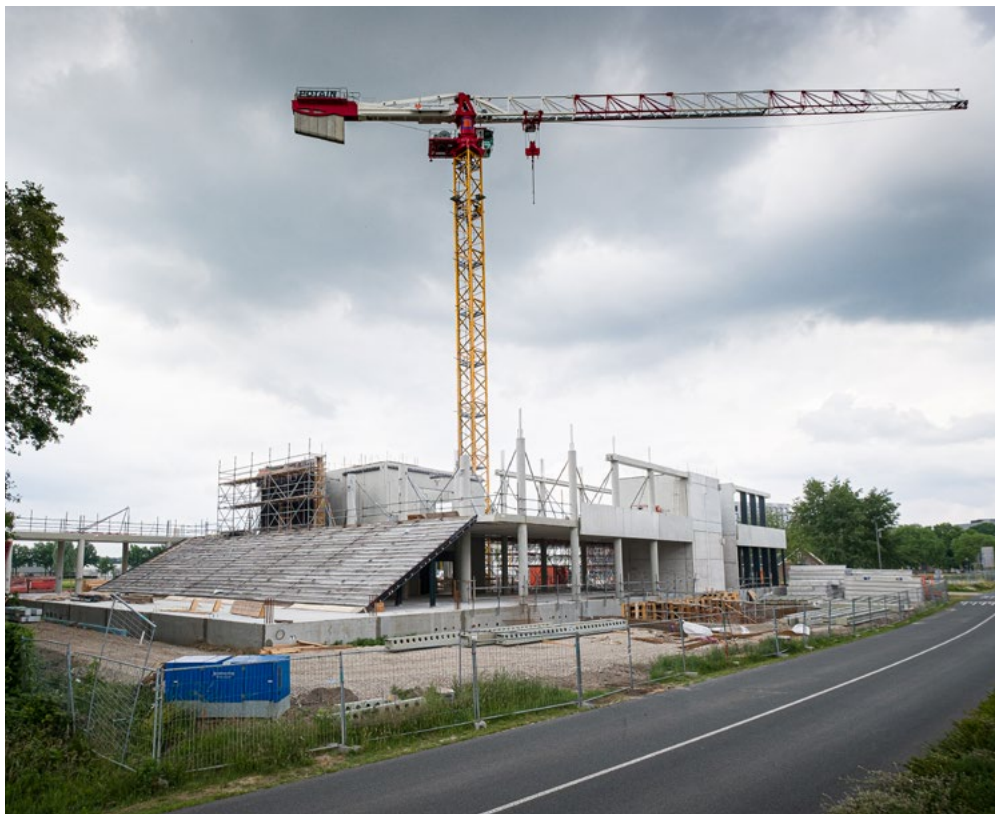
▲ Aurora, het derde onderwijsgebouw dat nu in aanbouw is.
