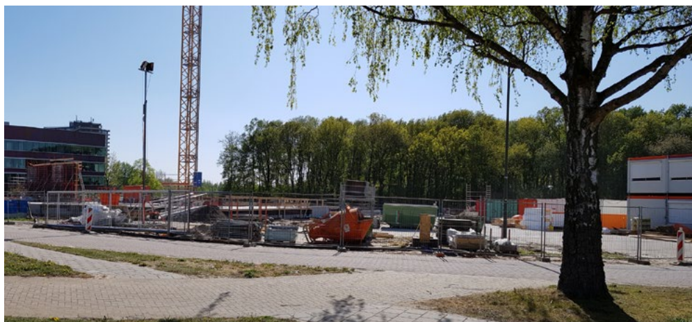
▲ Het derde onderwijsgebouw in aanbouw.
